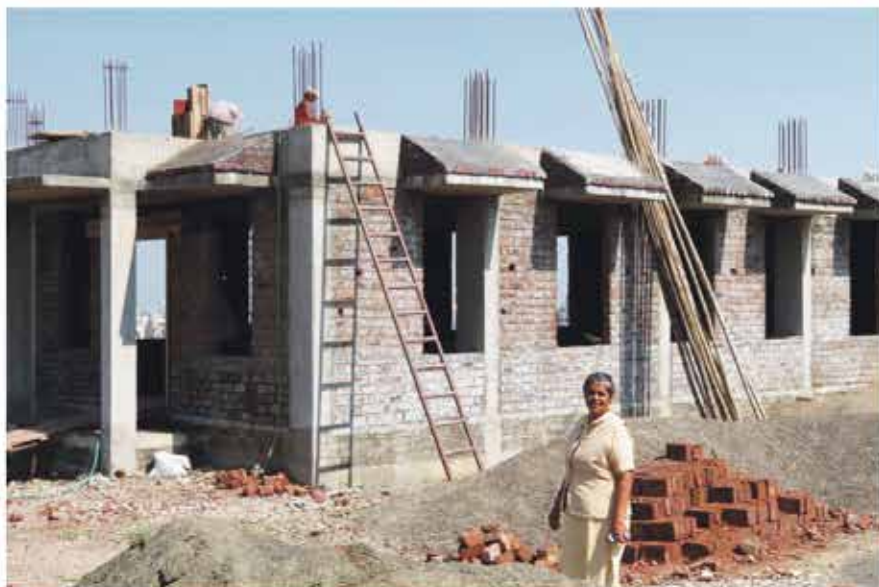
Sr. Rowena vor dem Rohbau des neuen Gesundheitszentrums in Pune. FREUNDE ANNA DENGEL (4)
